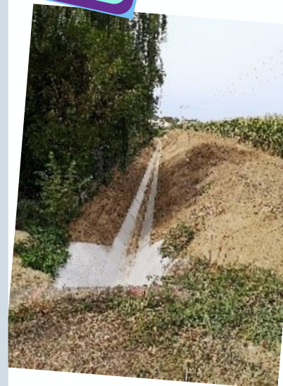
TRAVAUX FOSSÉ "V7"
