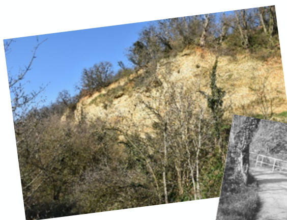
Effondrements de la falaise le long de la ligne Galoche
